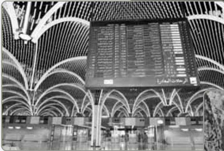
▲ Terminal reconstruida en el aeropuerto internacional de Bagdad.
