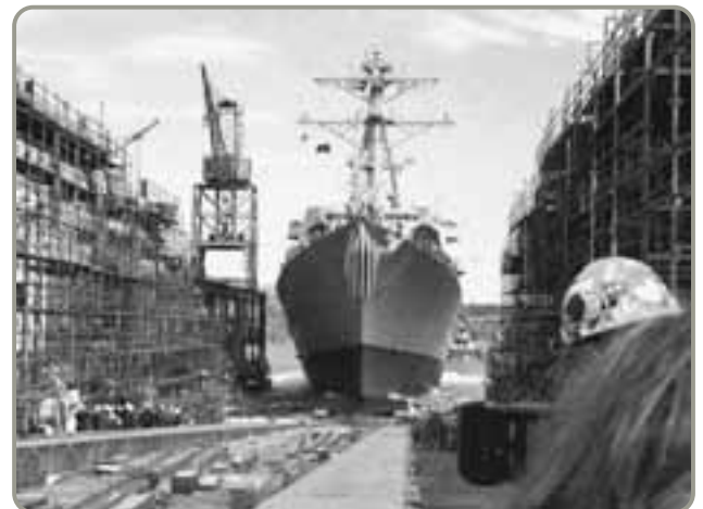
▲ En la construcción de barcos, hay un espacio limitado adyacente a la distribución de posición fija. Los astilleros llaman plataformas a estas áreas de carga, y se asignan en diferentes periodos a cada contratista.
